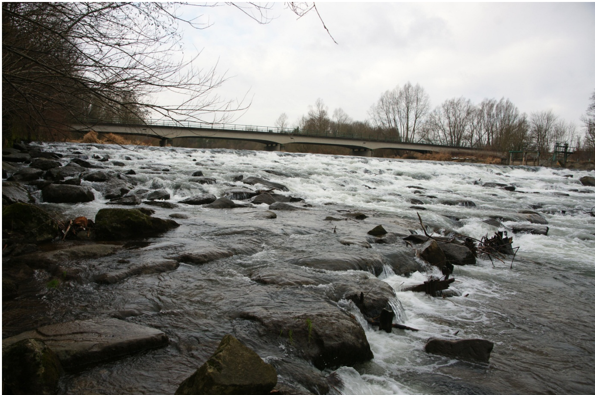
Abb. 13: Sohlrampe von flussab der Hohen Brücke gesehen (Foto: C. Ratschan)
