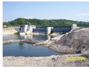
Kraftwerk in der Ybbs bei Kemmelbach
